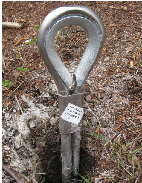
TESTATA DI ANCORAGGIO A DOPPIA FUNE
