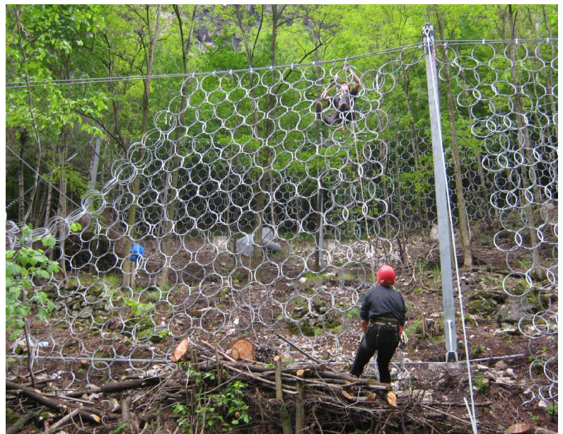
FASE DI MONTAGGIO DELLA BARRIERA
