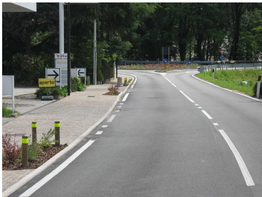
Vista opera realizzata
