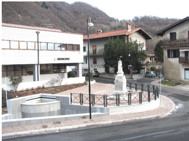
Vista opera realizzata
