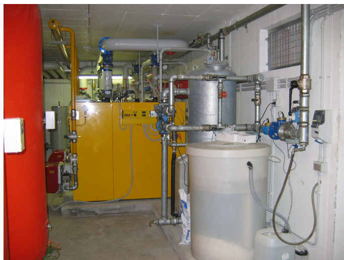
La centrale termica con le sette linee di mandata lato riscaldamento e una lato sanitario (accumuli da 2000 litri) a valle del sistema di trattamento acqua
