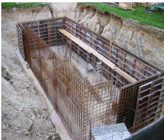
Pareti in elevazione
