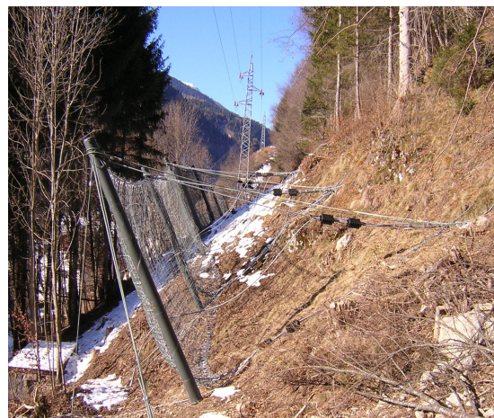
nuova barriera paramassi ad alto assorbimento
