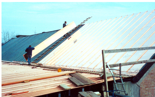
La posa delle lamiere di rame derivate da nastro continuo tagliato e formato mediante piegatura in cantiere
