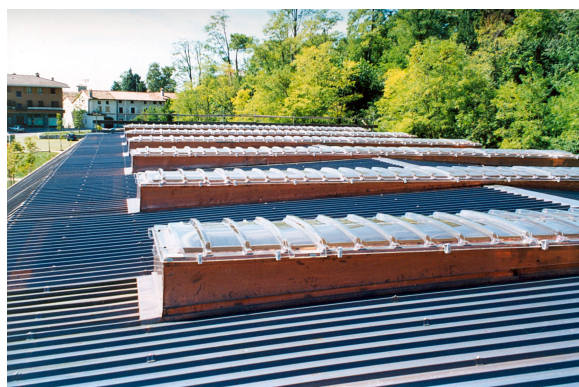
La parte piana della copertura con i "cassoni" porta lucernai
