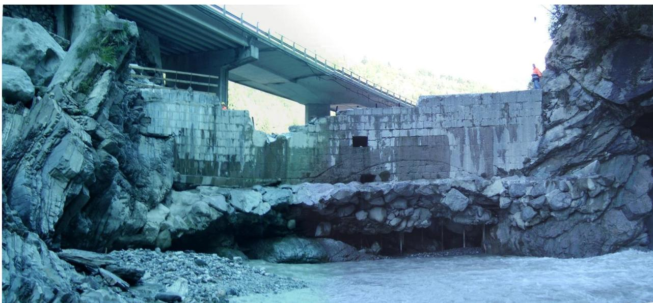
Figura 3. Impressionante escavazione al piede dell'opera e ampio sbreccio del corpo.
