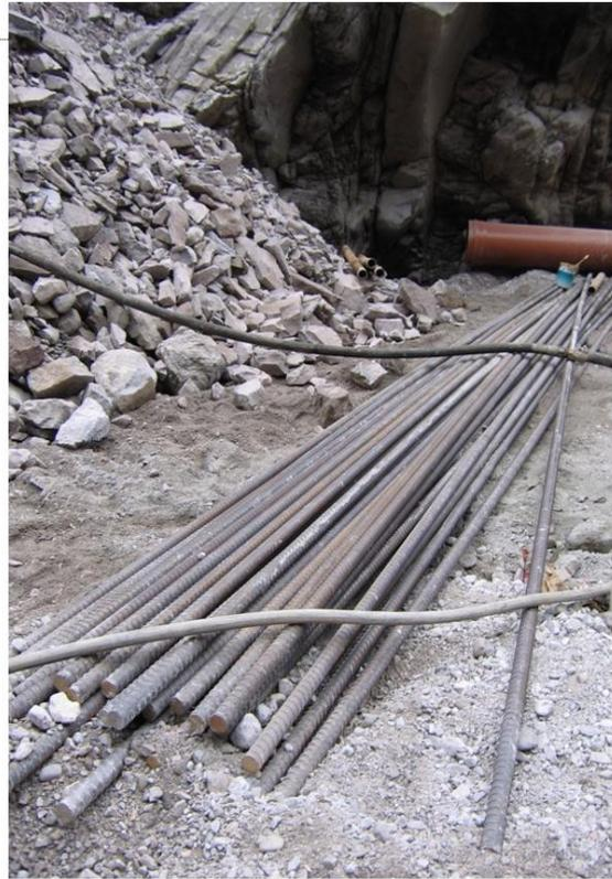
Figura 13. Fasi di realizzazione degli ancoraggi di fondazione. A sinistra perforazione in roccia con martello fondo-foro di diametro 140mm, a sinistra le barre di armatura dei micropali Gewi® d50 mm.
