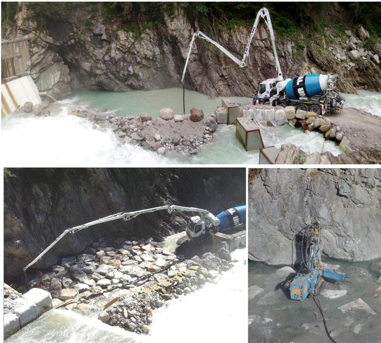
Figura 18. Fasi di completamento del bacino di dissipazione. In alto il getto in immersione dello zatterone in calcestruzzo, in basso a sinistra l'intasamento degli interstizi tra i massi formanti la corazzatura, in basso a destra la perforazione degli ancoraggi dei massi.
