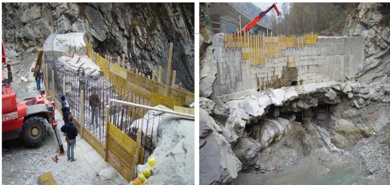
Figura 12. Ripristino del corpo dell'opera e costruzione del cordolo di protezione posteriore.
