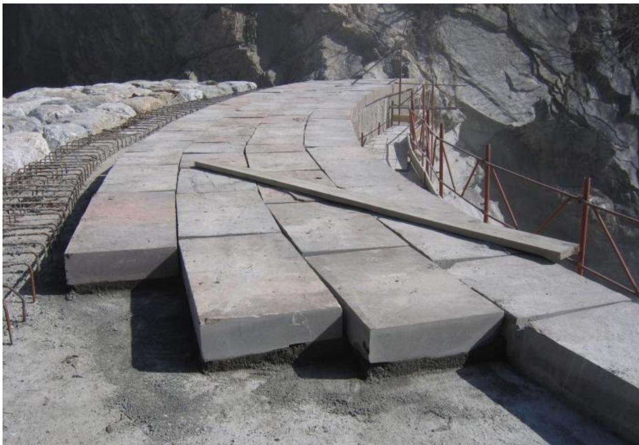
Figura 6. Formazione del rivestimento superficiale della gaveta con lastre in porfido di grosso spessore. A sinistra l'armatura del cordolo di protezione.
