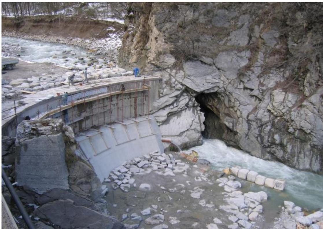
Figura 15. Fasi di lavorazione. In evidenza la galleria di by-pass.
