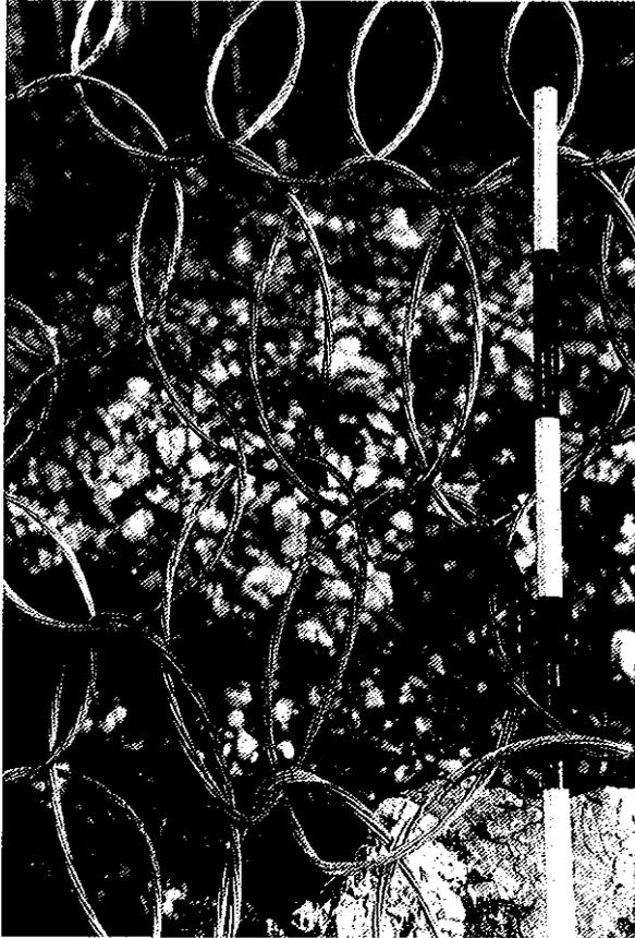
Fig.14 - Gemona del Friuli (UD): evidente fenomeno di ovalizzazione della rete, a causa dell'ingranamento del blocco sulla rete, conseguente all'impatto.
