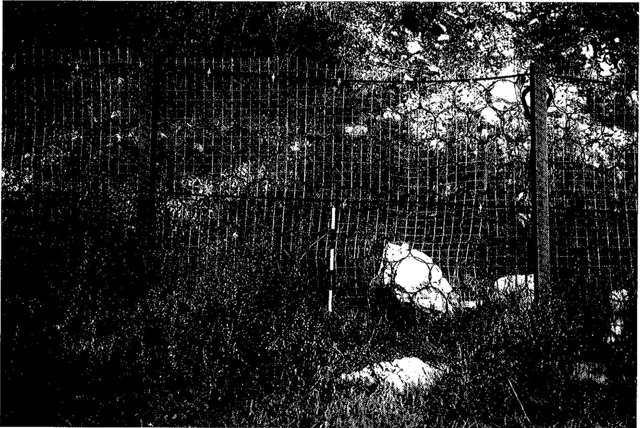
Fig. 10 - Forni Avoltri (UD): impatto di un blocco calcareo sulla barriera. Si noti in particolare l'assenza di deformazioni negli anelli di rete prossimi alla zona d'impatto, a causa della bassa energia cinetica posseduta dal blocco.
