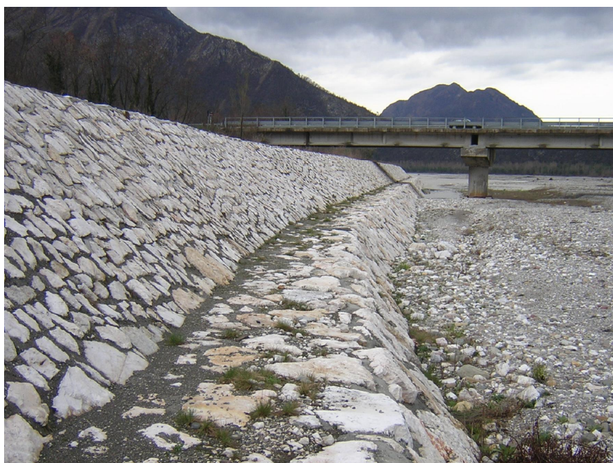
Figura 20: Berma di camminamento su mantellata arginale lungo il fiume Tagliamento (Amaro, UD).
