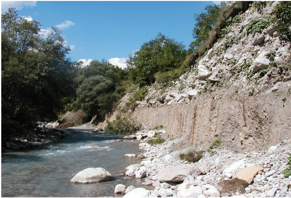
Figura 13: Erosione spondale sub-verticale lungo il torrente Pesarina (Prato Carnico, UD).
