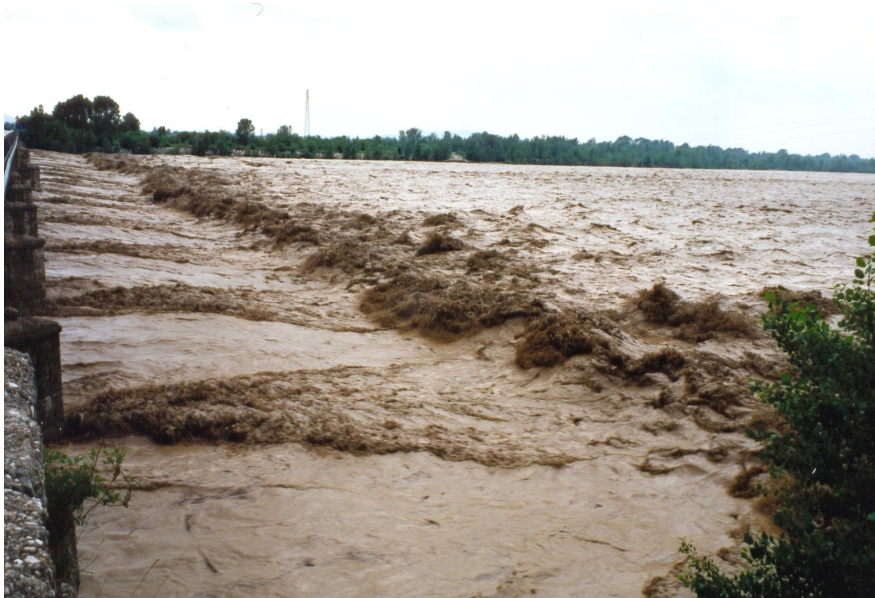
Figura 2: Ponte di Braulins sul fiume Tagliamento (UD): risalto a valle del manufatto in occasione dell'evento di piena del 21-22 giugno 1996.
