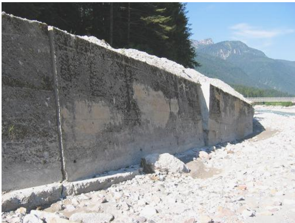
Figura 12: Perdita di capacità portante e collasso di un muro spondale lungo il fiume Fella presso Malborghetto (UD), a seguito dell'alluvione del 29 agosto 2003.
