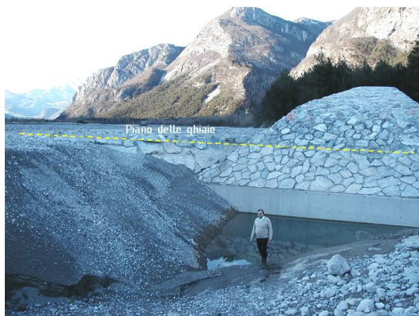
Figura 17: Escavazione allo spigolo di un repellente sul fiume Tagliamento (Tolmezzo, UD).
