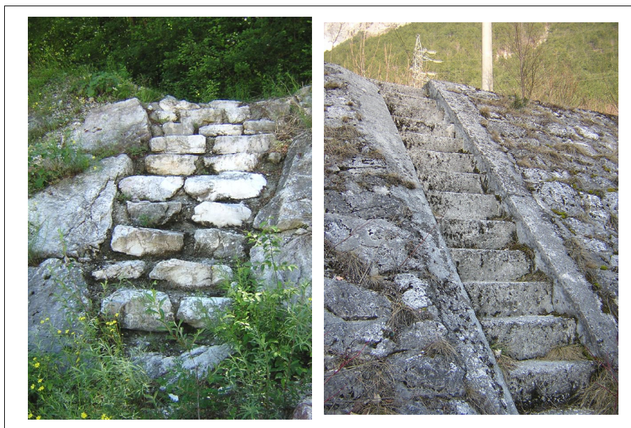
Figura 19: Esempi di accessi all'alveo ricavati su scogliere e mantellate di argini fluviali.
