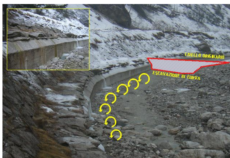
Figura 16: Erosione al piede di difesa spondale posta in curva sul torrente Aupa (Moggio, UD).
