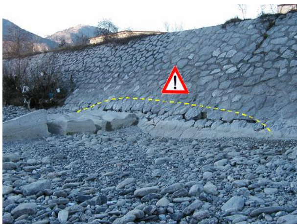
Figura 18: Lesione di mantellata arginale causata dal collasso di un repellente sul fiume Tagliamento (Tolmezzo, UD).
