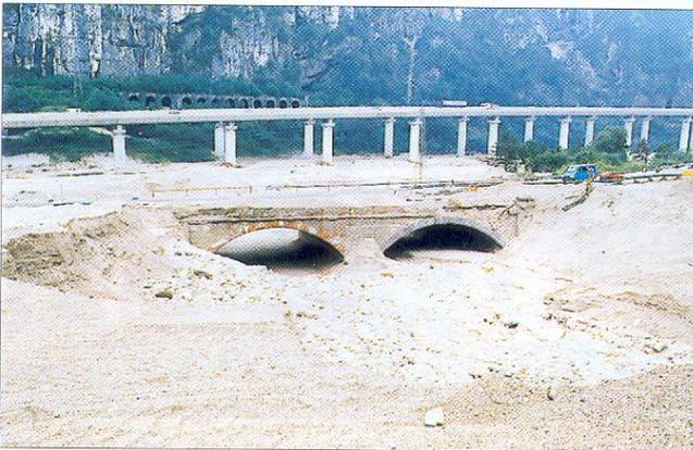
Figura 9 - Potenti depositi di colata messi in posto sulla conoide torrentizia del Rio Molino, prima della confluenza con il F. Fella tra Dogna e Chiusaforte. I detriti hanno ostruito la luce del ponte e sovralluvionato la S.S. 13 Pontebbana.
