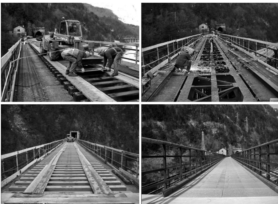
Figure 16. La costruzion de gbove solete. Adalt, si gjavin lis traviersinis de ferovie e i cjamenti in lamiere. Dabàs a man çampe si metin jù lis gnovis traviersis in laris lamelâr, a man drete la solete finide come che si presente cumò. Che si fasi câs ae messe in sigurece des maestrancis cun imbragadure alpinistiche e colegament cun dissipatôr aes liniis vite laterâls.
