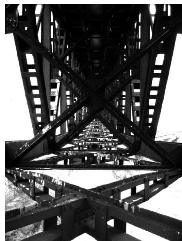
Figure 11. Fotografie de travadure tubolâr dal punt (il plan dai binaris al è adalt!). Come che si viôt, la vernâs e je stacade in diviersis parts des trâfs diagonâls inferiôrs de reticolâr, e si viôt il primer di colôr naranc (Març 2007).
